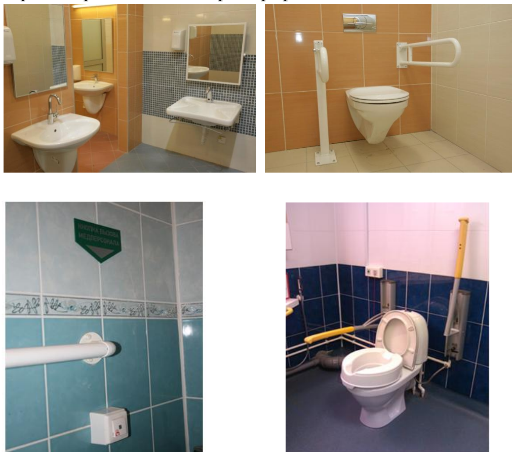
Примеры оборудования санитарно-гигиенических помещений 41
